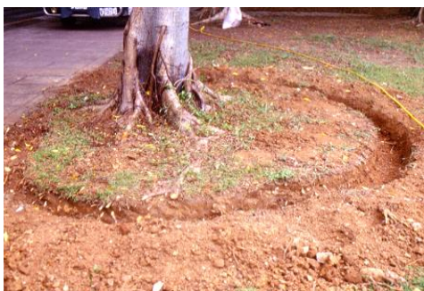
● 環狀掘溝埋施
